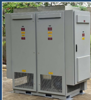
1001-2000 kW 480V Nema 3r Type HMI Controller
